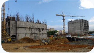
Construcción y Obras Civiles
